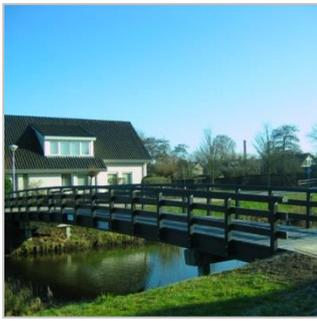
KLP® hat eine zu erwartende technische Lebensdauer von über 50 Jahren. Außerdem ist das Material, berechnet über die gesamte Lebensdauer, sehr vorteilhaft und preiswert, weil KLP® keine Wartung braucht. Im Vergleich zu Holz ist der Gebrauch von KLP® Kunststoff besonders sicher, weil das Material nicht splittert und doppelt so rutschfest ist, selbst wenn es nass wird. Wir produzieren Deckteile für Brücken, worauf Sie sorglos zu Fuß gehen können.
