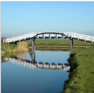
Diese Konstruktion besteht völlig aus Kunststoff, die tragenden Teile sind jedoch mit Stahl verstärkt. Die Verwendung von stahlverstärkten Kunststoffbalken ermöglicht es, Brücken mit viel größerer Spannweite zu bauen. Dies bedeutet, dass, im Gegensatz zur traditionellen Bauweise, weniger Pfähle nötig sind. Dadurch werden Material- und Baukosten eingespart.
