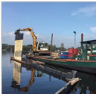
Quand il s'agit de barrage ou de soutènement, la **KLP® Combi Palplanche** vous offre une solution abordable et durable. Cette palplanche est constituée de planches de pin (Résistance Classe C24) qui sont insérées dans le haut de la palplanche KLP. Le plastique utilisé est un polyéthylène recycle.
