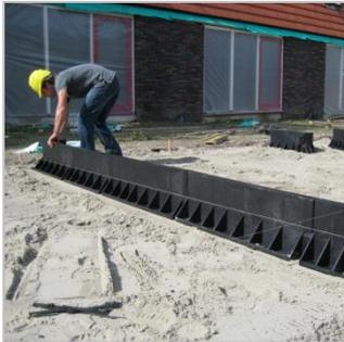
**KLP® Fundamentbalken** sind für Leichtbaustrukturen wie Schuppen und Gartenlauben gestaltet. Die Fundamentbalken sind einfach zu platzieren und bieten viele Vorteile im Vergleich zur Alternativen aus Beton oder Holz. Sieben Gründe um sich für KLP® Fundamentbalken zu entscheiden:
