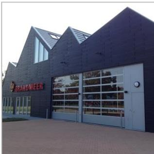
**KLP® Fassadenpaneele** können auf Schul- und Bürogebäuden, Wohnungen, Schuppen und Gartenzäune verwendet werden. Sowohl horizontale als auch vertikale Montage ist möglich. Die Paneele werden mit einem H- Profil aus Aluminium befestigt. Dieses Profil sorgt nicht nur für eine unsichtbare Montage, sondern ermöglicht auch das Ausdehnen und Zusammenziehen des Materials.
