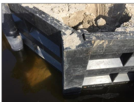
KLP® Paal t.b.v. RapidRetain hoekopstelling. Geleverd met 1-zijdige uitsparing (50x40mm). Aannemer dient zelf de andere uitsparing onder de juiste hoek te frezen op het werk.
