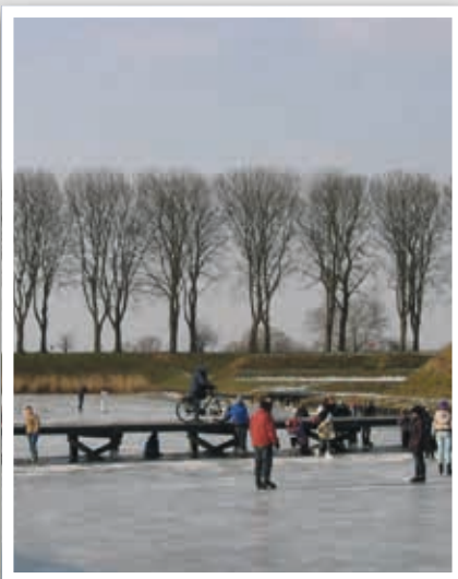
KLP® Steigers, project vestingwerken Stevensweert.
